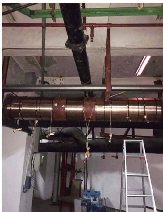
Paso 1: Se instalaron las bandas impulsoras
