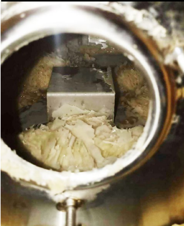
La vaporera antes del tratamiento
