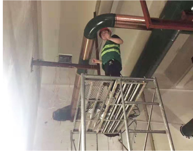
Se instaló Vulcan S350 en la tubería de agua de refrigeración por circulación para los equipos de tejido.
