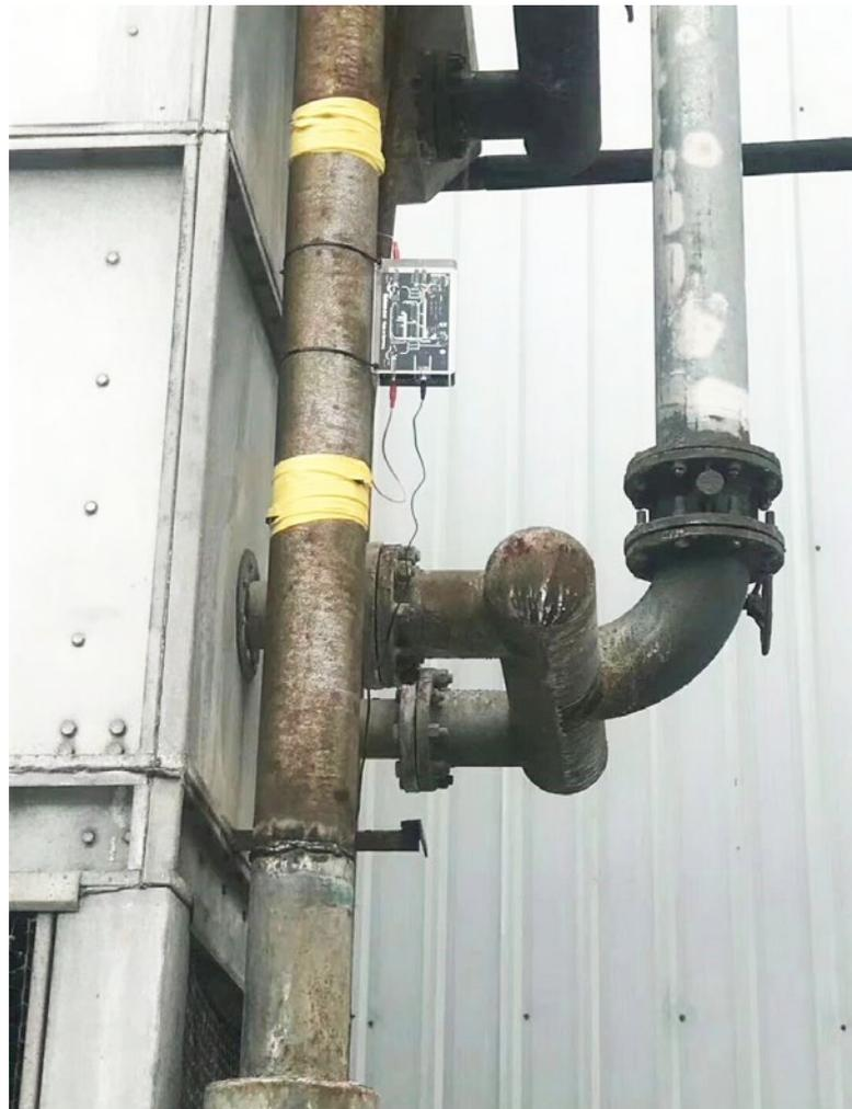
Se instaló un equipo Vulcan S10 en la tubería de agua principal de la torre de refrigeración.
