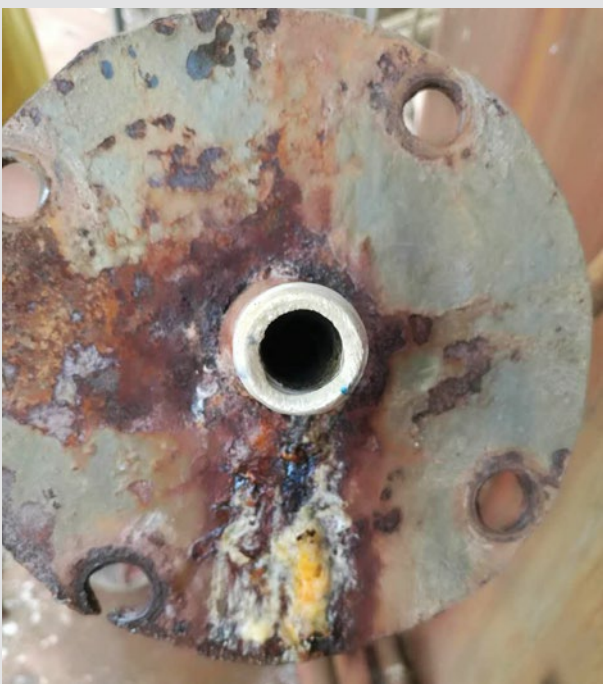
La planta de FGD antes de instalar Vulcan.
