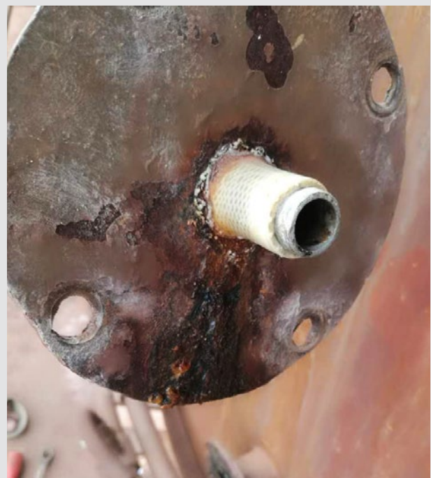
25 días después de la instalación de Vulcan la situación de los sedimentos de cal ha mejorado sustancialmente.
