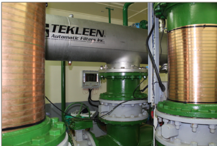
La unidad Vulcan S500 instalada en el cuarto de bombas.
