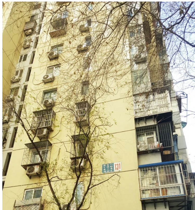
Edificio Xizhimen No.131, Pekín.
