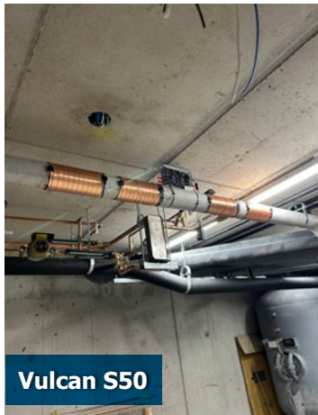
Vulcan S50 en la circulación principal de agua
