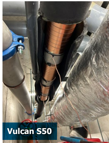
Vulcan S50 en la circulación principal de agua
