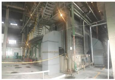
Vulcan S100 fue instalado en la tubería de entrada de la caldera No. 2. Después de 20 días, la tubería de suministro de aqua se ha despresurizado en 0,12 MPa.
