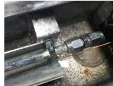
10 de mayo: En la máquina 2 sin Vulcan, la cal y las bacterias aún están en las paredes y en el fondo del depósito de agua.
