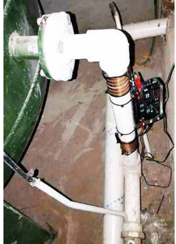
El Vulcan 5000 se instaló en la tubería principal de agua en el centro de baño.
