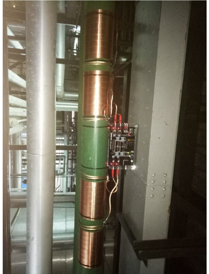
Se instaló un equipo Vulcan S25 para tratar el enfriador antiguo.
