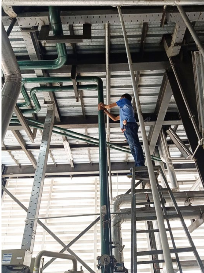
Instalación de Vulcan S25 en el nuevo enfriador.
