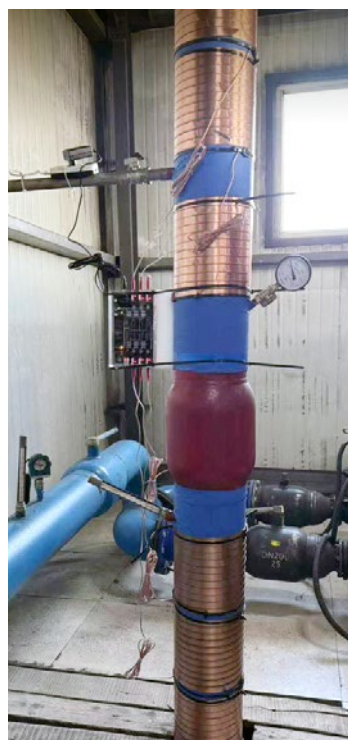
Vulcan S150 en la tubería de alimentación de la caldera de calefacción
