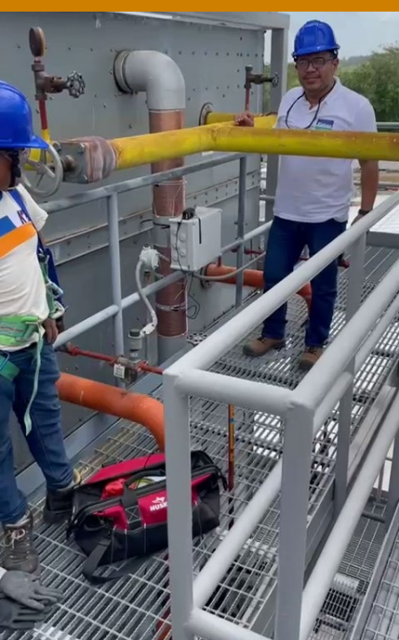
在6英寸（DN150）PVC管道上安装Vulcan S100
