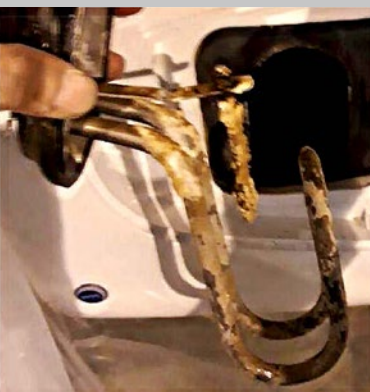
图4和5. 在沃肯(Vulcan)安装后三周, 初步的水垢已经消失。
