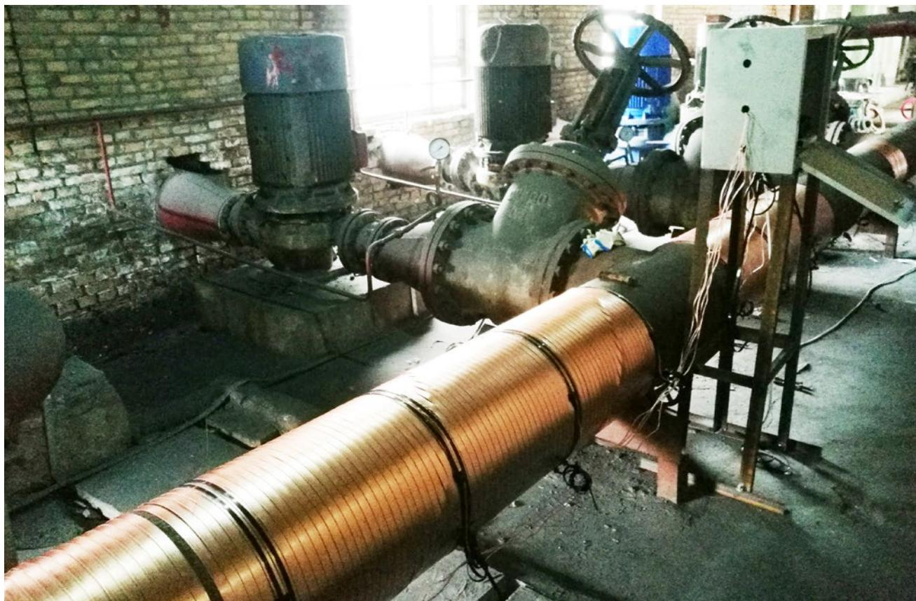
Vulcan S500 解决循环冷却水系统结垢严重的问题, 并且停止了软水器的使用。
