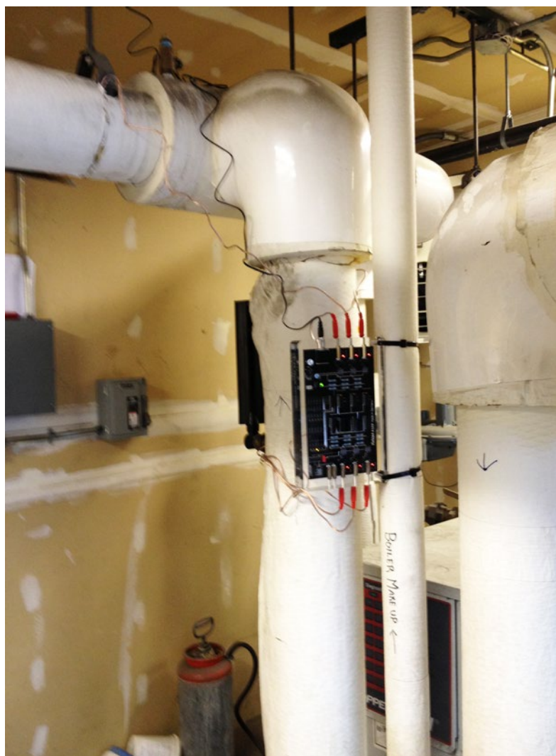
Vulcan S100 安装在银行的2台热水锅炉前，所有的脉冲带都包裹在绝缘层之下。
