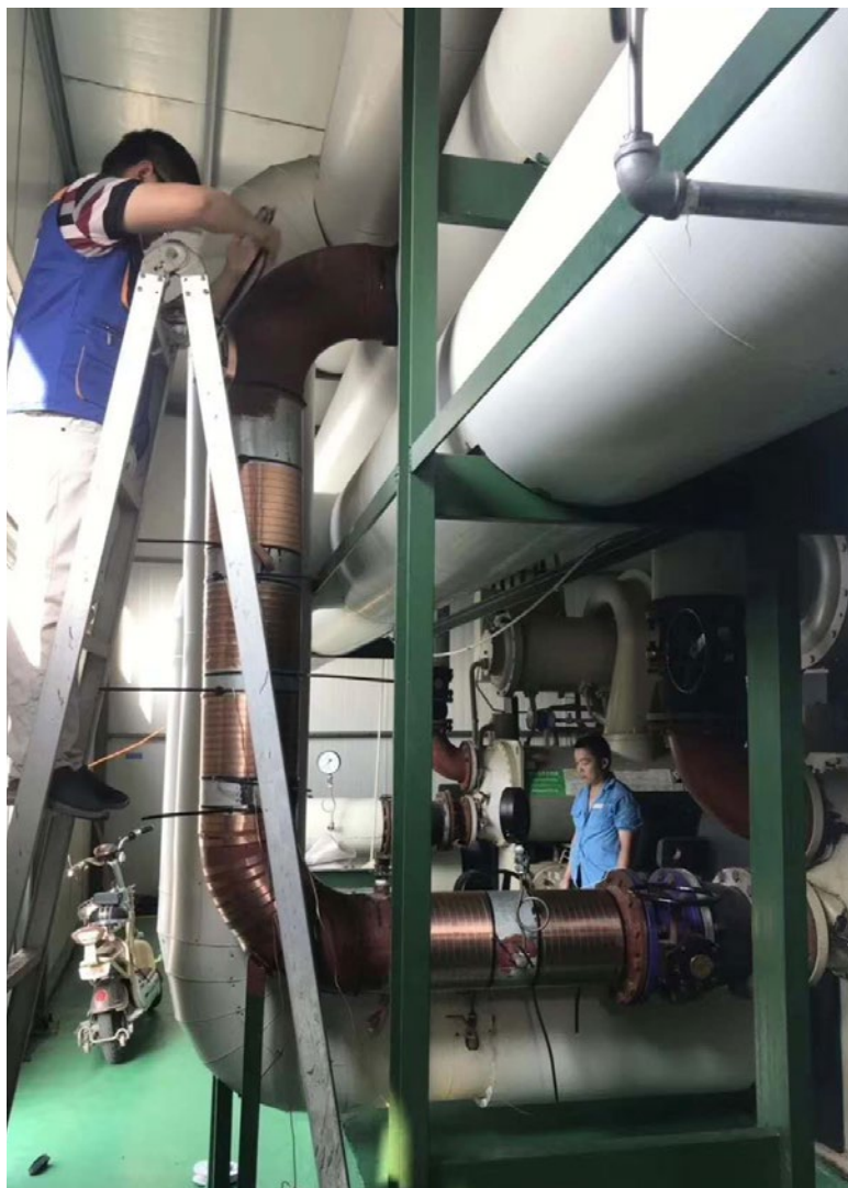
Vulcan S250 安装在空调冷却水进水口主管道
