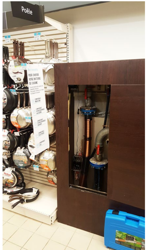
Vulcan S25安装在主水管中，用于处理整栋建筑
