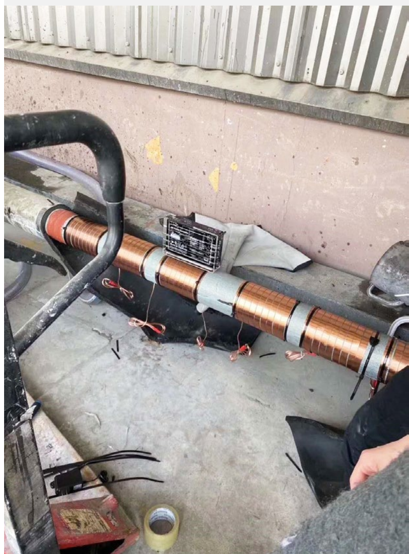
去除管道保温层，再安装上Vulcan S100
