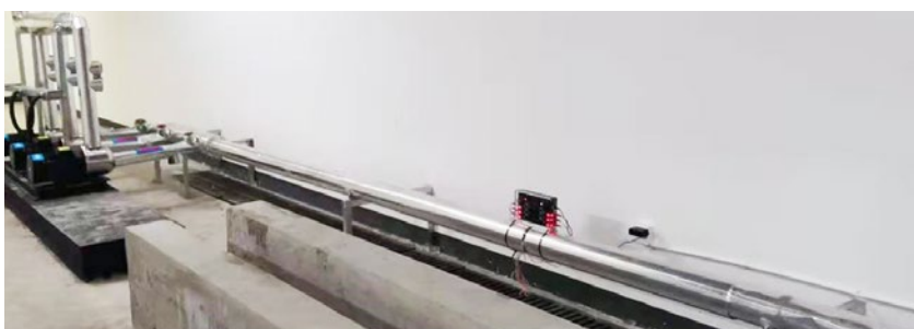
1台S100安装在10号公寓楼 - 空气能循环水系统
