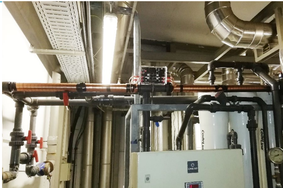
Vulcan S25 安装在主管道入口处, 用于处理冷却塔。
