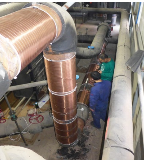
Vulcan S500 安装在CT机换热站。
