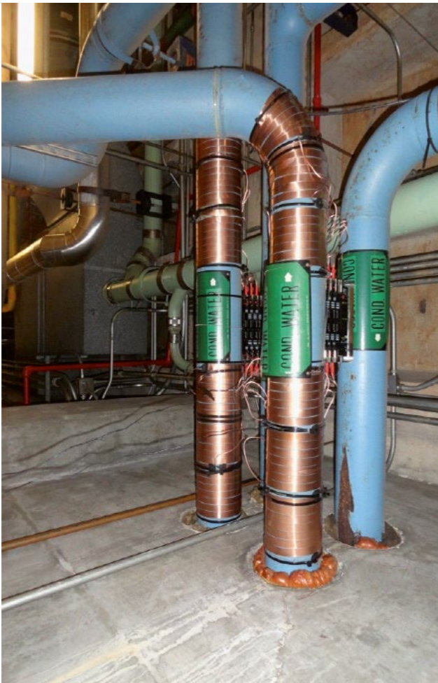
安装在双制冷机上的Vulcan S100装置
