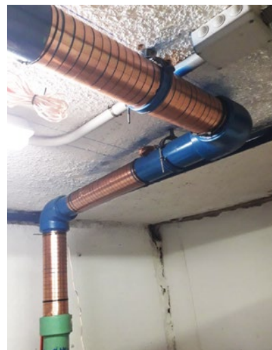
第1步: 安装脉冲带
