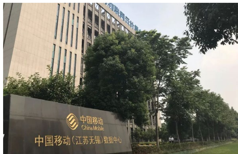
中国移动(江苏无锡)数据中心
