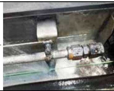
5月10日: Vulcan 5000在机器1前安装3个月后, 水垢已经减少80%, 生物膜已经完全消失。
