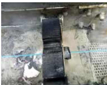
5月10日: 还没有安装沃肯(Vulcan)的机器2, 水垢和生物膜仍然沉积在墙壁上与线圈。
