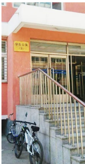
北京化工大学 - 学生公寓外观
