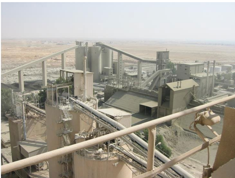
ADRA 水泥建材公司
