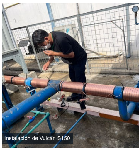
Tubería aislada tras la instalación de Vulcan S150
